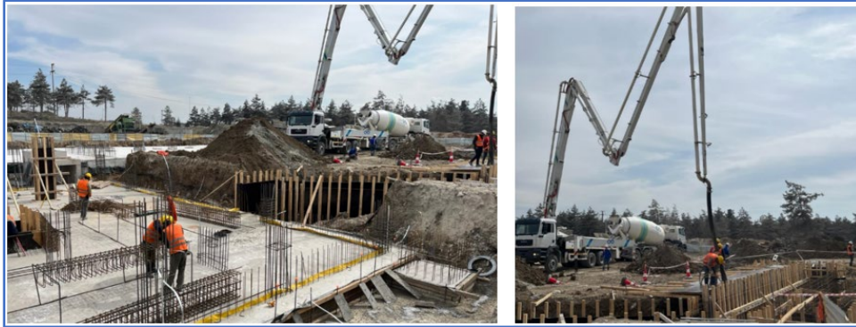
Şekil 3. AIGK tesisinin inşaat çalışmalarından bir görünüm
